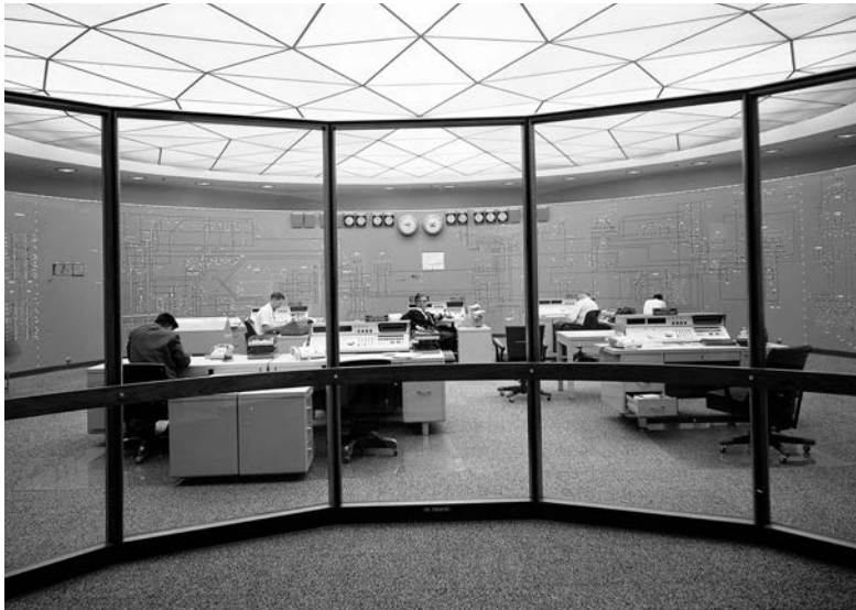
Das Kontrollzentrum für die Stadtbeleuchtung von Seattle, 1968. Credit: Seattle Municipal Archives.
